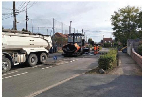
Réfection de la couche de roulement d'une partie de la rue F. Decarpentry
